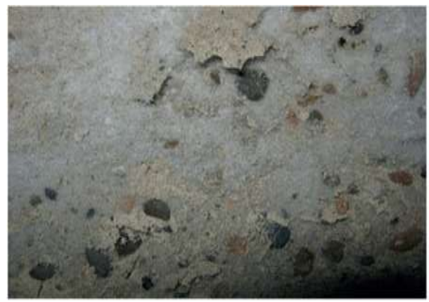
Hình 4. Các máng bê tông bị mất tính chất cơ học, bị tách rời ra khỏi công trình do thaumasite
