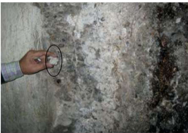
Hình 4. Các máng bê tông bị mất tính chất cơ học, bị tách rời ra khỏi công trình do thaumasite
