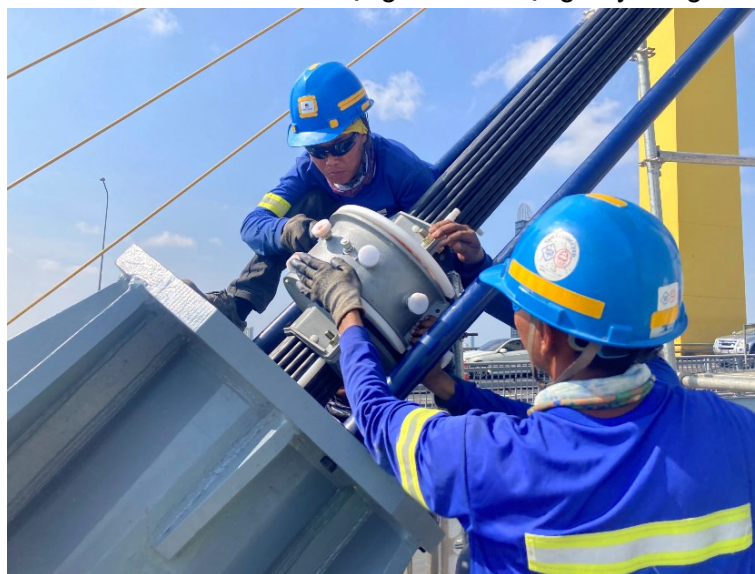
Hình 2. Lắp đặt bộ giảm chấn cho dây văng
