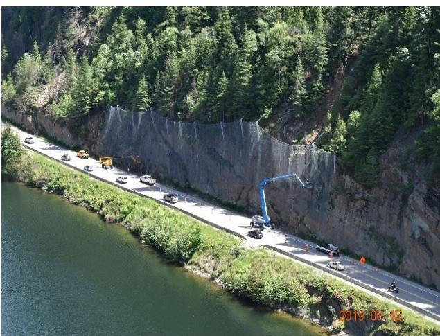
Hình 2. Lưới thép được sử dụng chống sạt lở, đá rơi ở thung lũng Gap- Canada (nguồn TranBC)
