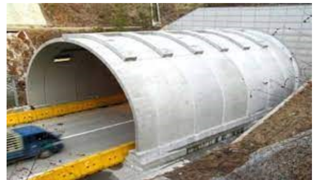
Hình 17. Lắp ghép mái vòm chịu lực và hoàn thiện mối nối [29]
