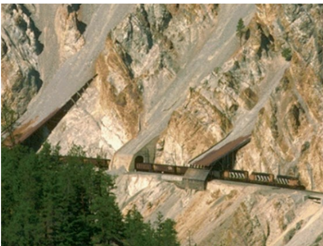
Hình 4. Hầm mái dốc làm chệnh hướng đá rơi bảo vệ đường sắt (nguồn Duncan)
