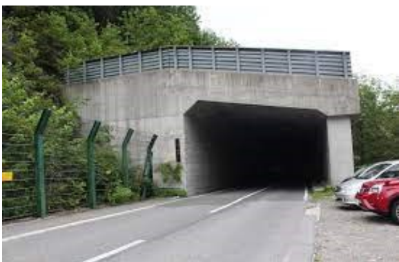
Hình 12. Cấu tạo hầm dạng khung trên đường Nagano Prefectural, Nhật [24]
