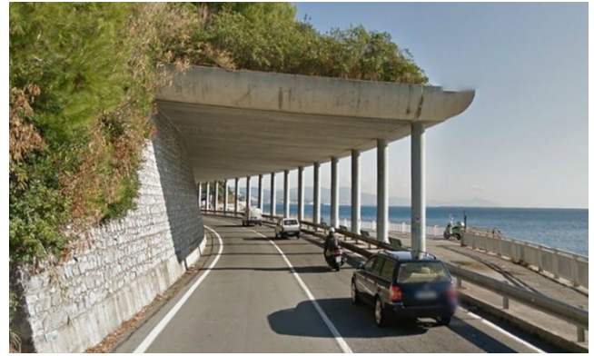
Hình 6. Hầm với mái bằng (nguồn Larimit)
