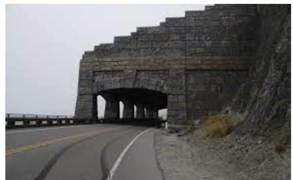
Hình 14. Hầm chống đá rơi bằng đá (Hầm Rain Rock) [26]
