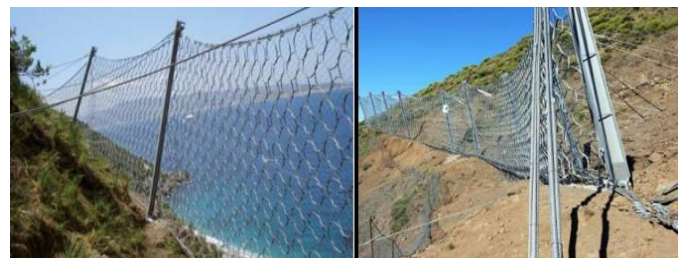
Hình 3. Hàng rào Rockfall Barrier tại một số khu vực ở Ý và Tây Ban Nha
