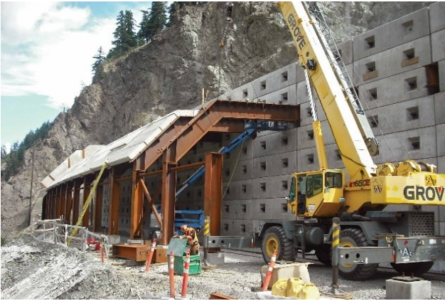
Hình 16. Hầm chống đá rơi gia cố bằng cáp neo [28]
